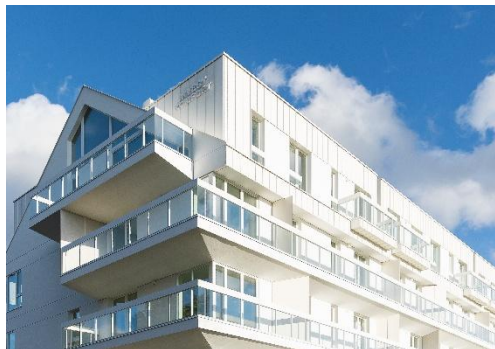
foto. budynek o numerze administracyjnym nr 77 widziany od strony ul. Wita Stwosza, ujęcie w kierunku dzielnicy Wrzeszcz
